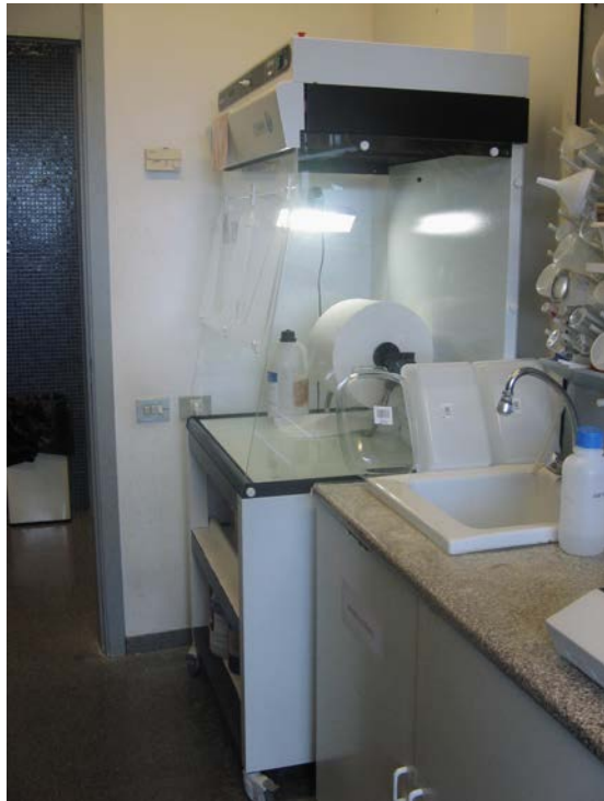
Cabina d'extracció de gasos
